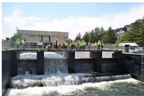
Фигура 5. Снимка на енергогасителя на ПСПВ Бистрица и схема на водобойния кладенец
